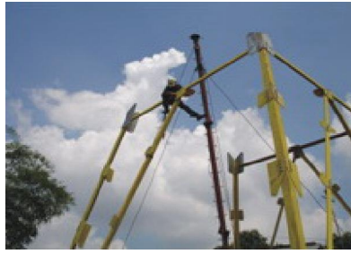
Lắp dựng trụ Anten
