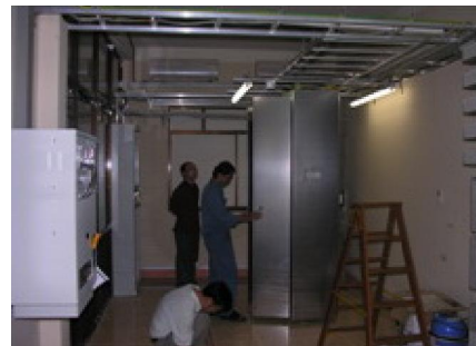
Xây dựng các đài trạm viễn thông cho các nhà cung cấp dịch vụ
