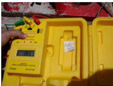
Khảo sát tiếp đất chống sét cho các công trình viễn thông
