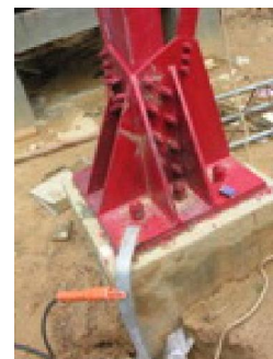
Thi công tiếp đất chống sét cho các trụ Anten
